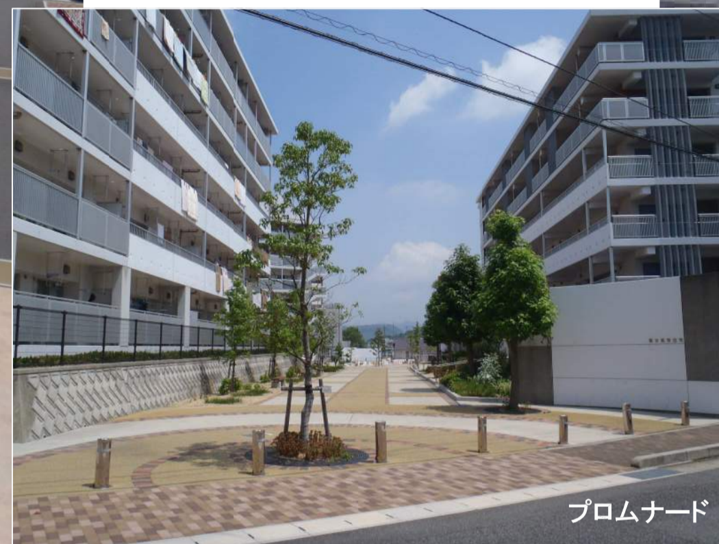
南側 全景(完成)
